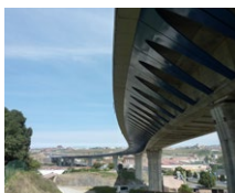
Viaducto de Trapagaran (ES)
