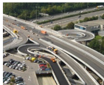
Bridge Glattzentrum (CH)
