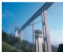
Talübergang Lavant (AT)
