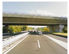
Val Freghizia Bridge (IT)
