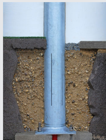
Masten og mastens slidser udgør sammen med tildækningen, mastens eftergivelighed.
